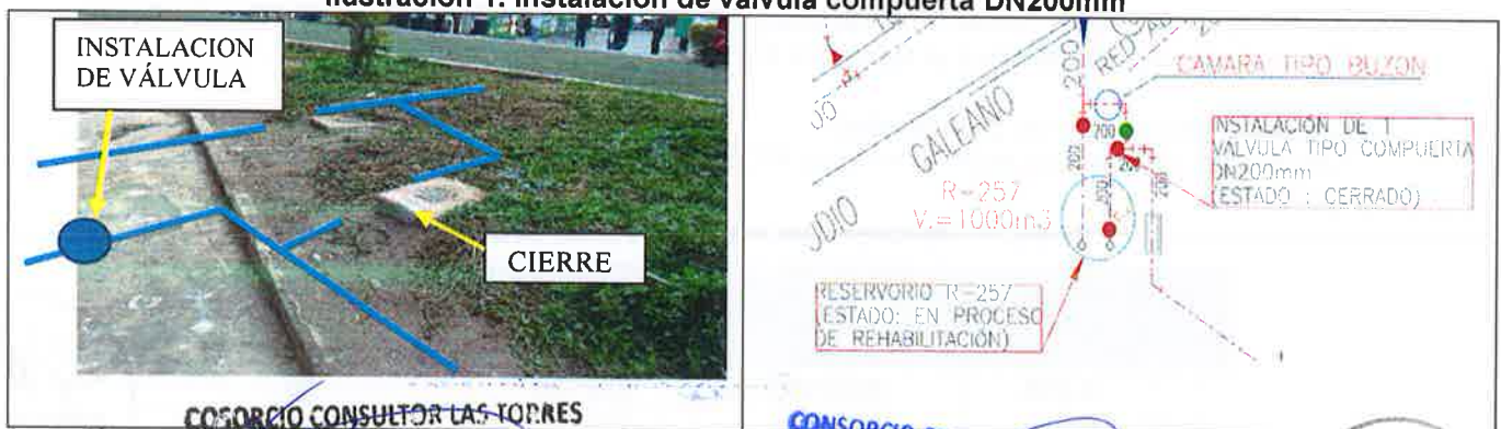
Ilustración 1. Instalación de válvula compuerta DN200mm
